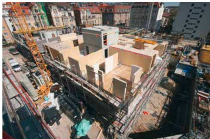
Wie die Stadt weiterbauen? Die Erstellung dieses Gebäudes einer Baugemeinschaft im Stuttgarter Westen ist klimaneutral: Die Bäume für das Bauholz haben beim Wuchs so viel CO 2 aufgenommen, dass dies das bei der Herstellung der anderen Baustoffe und deren Verarbeitung erzeugte Treibhausgas kompensiert.
